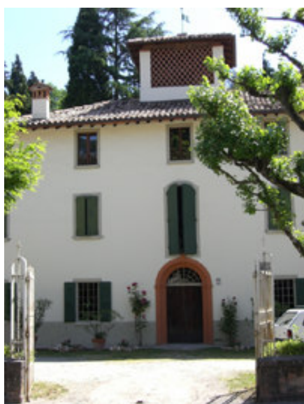
LA PIOPPA: La facciata
