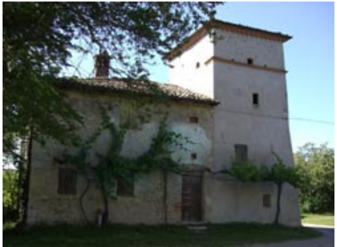
LA VALLE: L'EDIFICIO AD USO ABITATIVO
